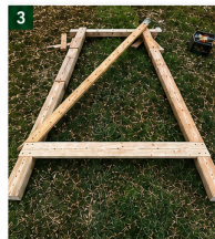
3 Diagonalstrebe montieren und Überstände oben und unten absägen.
