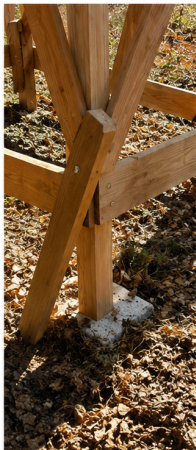
Bodenanker am Hauptholm befestigt.
