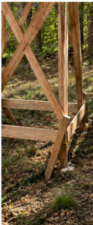
Bodenanker schräg vom Unterbau weg eingeschlagen.
