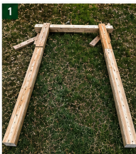
1 Hauptholme und Tragholme positionieren und Verbindungshölzer montieren.
