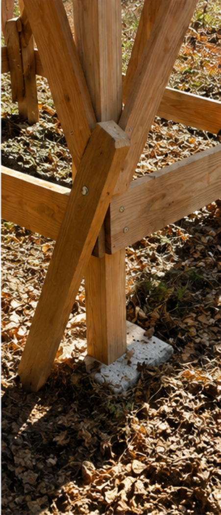
Bodenanker am Hauptholm befestigt.
