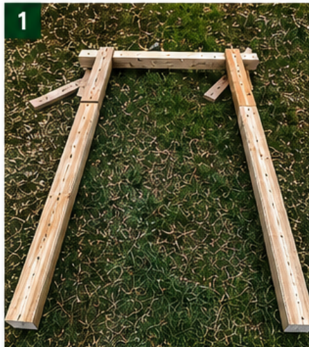
1 Hauptholme und Tragholme positionieren und Verbindungshölzer montieren.
