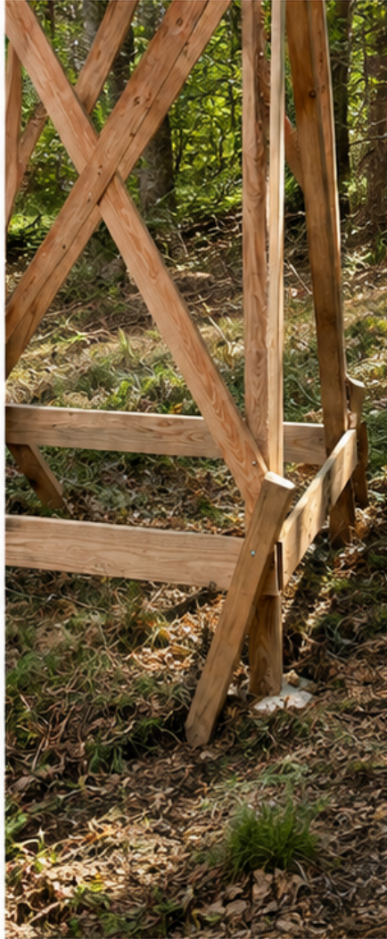
Bodenanker schräg vom Unterbau weg eingeschlagen.
